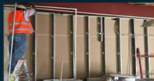
TRABAJOS DE TABLAROCA
