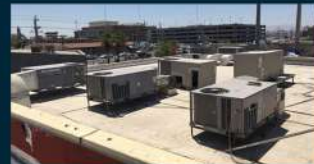
MONTAJE DE EQUIPOS AIRE ACONDICIONADO
